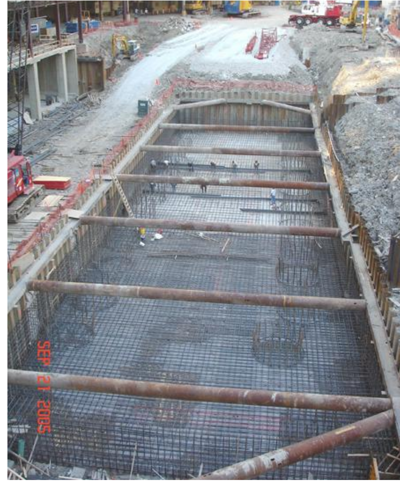
Preparation to pour tower core mat
