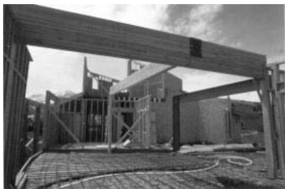
Garage door header.
